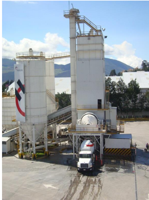
Figura 6. Carga del hormigón premezclado en el camión hormigonero
