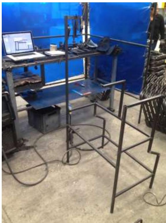
Figura 25 Ensamble de la estructura
