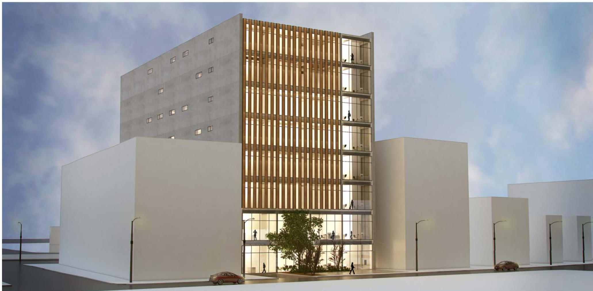
VISTA EXTERIOR PARTE POSTERIOR
