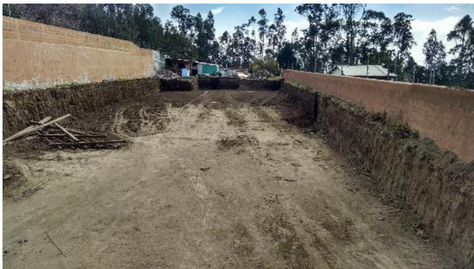
Ilustración 62 Vista del estado actual de las obras
