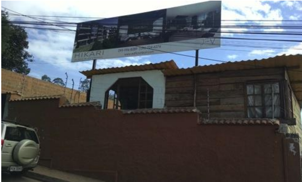
Ilustración 61 Valla in situ
