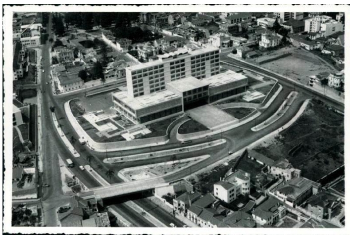
El centro cívico, condición original.
