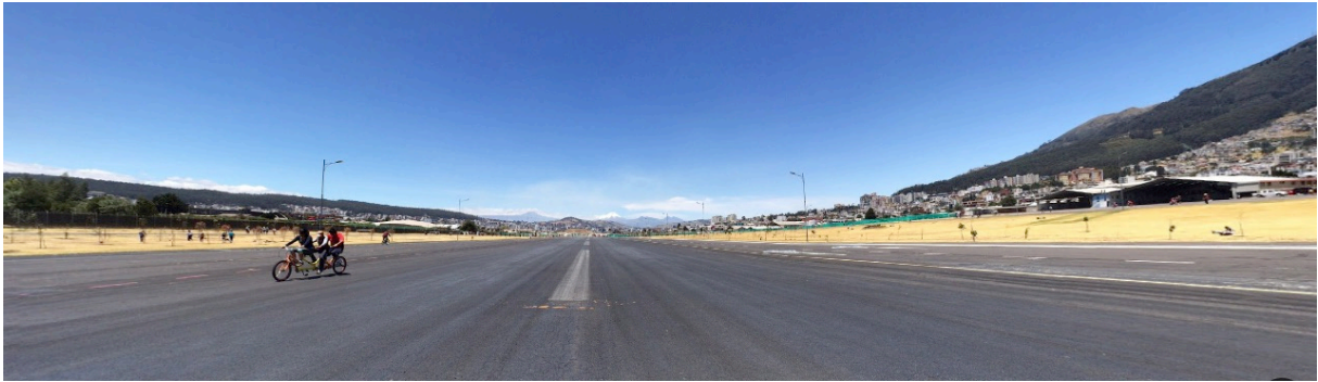
Figura 9. Imagen Google Earth, cabecera Sur.
