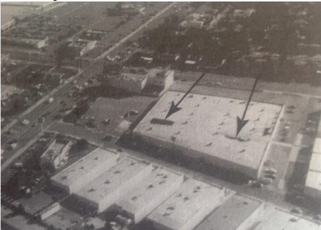
Figura 7-5 Esta grande estructura modular prefabricada sufrió separaciones en los diafragmas y colapso en el techo. Estas condiciones pueden ser vistas únicamente desde el interior de la edificación y son de gran amenaza. Marcar Inseguro
