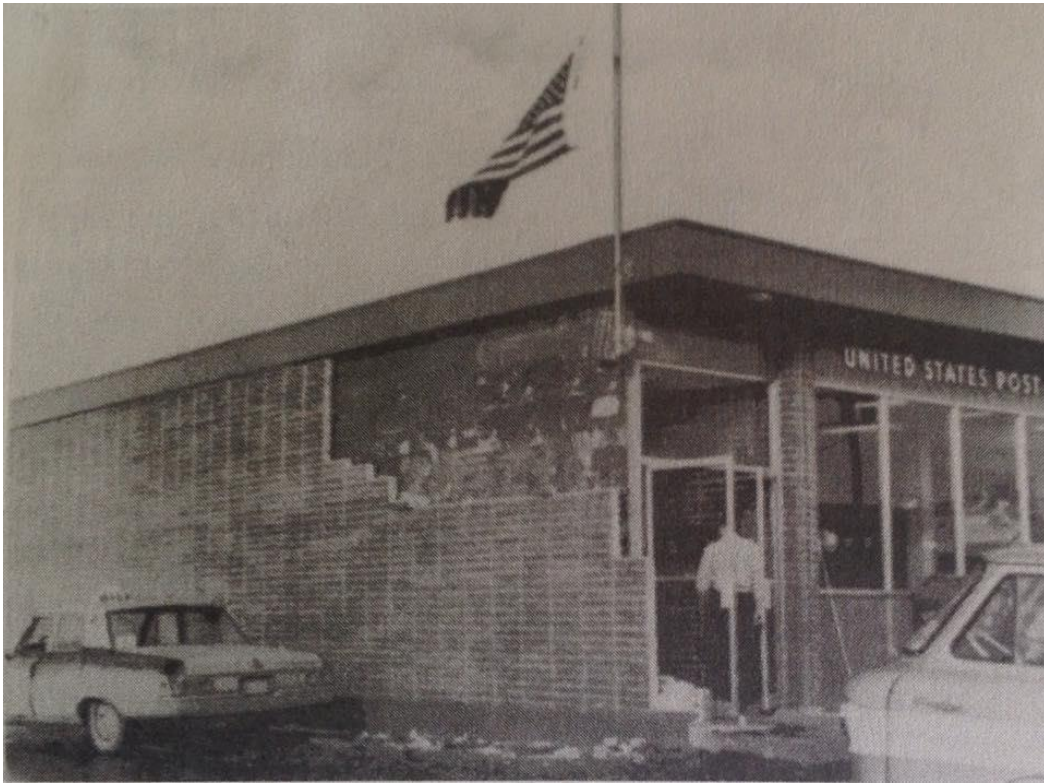
Figura 12-1 Fachaletas de ladrillo rotas que pueden presentar amenaza de caída de material. Marcar como Uso Restringido y barricar el área insegura.
