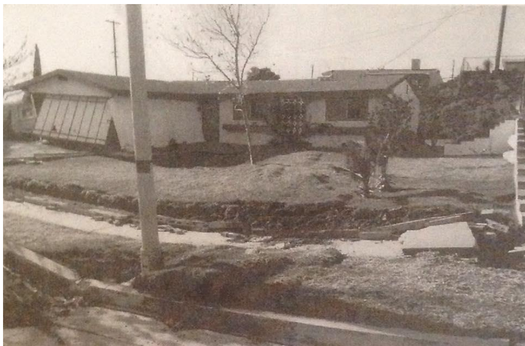
Figura 11-3 Casa estructuralmente dañada por el movimiento de suelos provocado por el terremoto de 1971 San Fernando, California. Falla en la superficie del terreno. Marcar Inseguro
