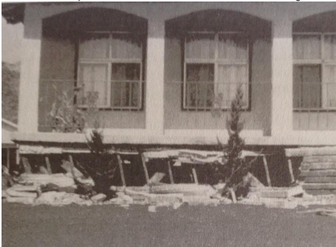
Figura 5-2 Existe un fallo estructural en el garaje el mismo que provoca su inclinación, también existe separación entre elementos de la estructura. Marcar Inseguro.
