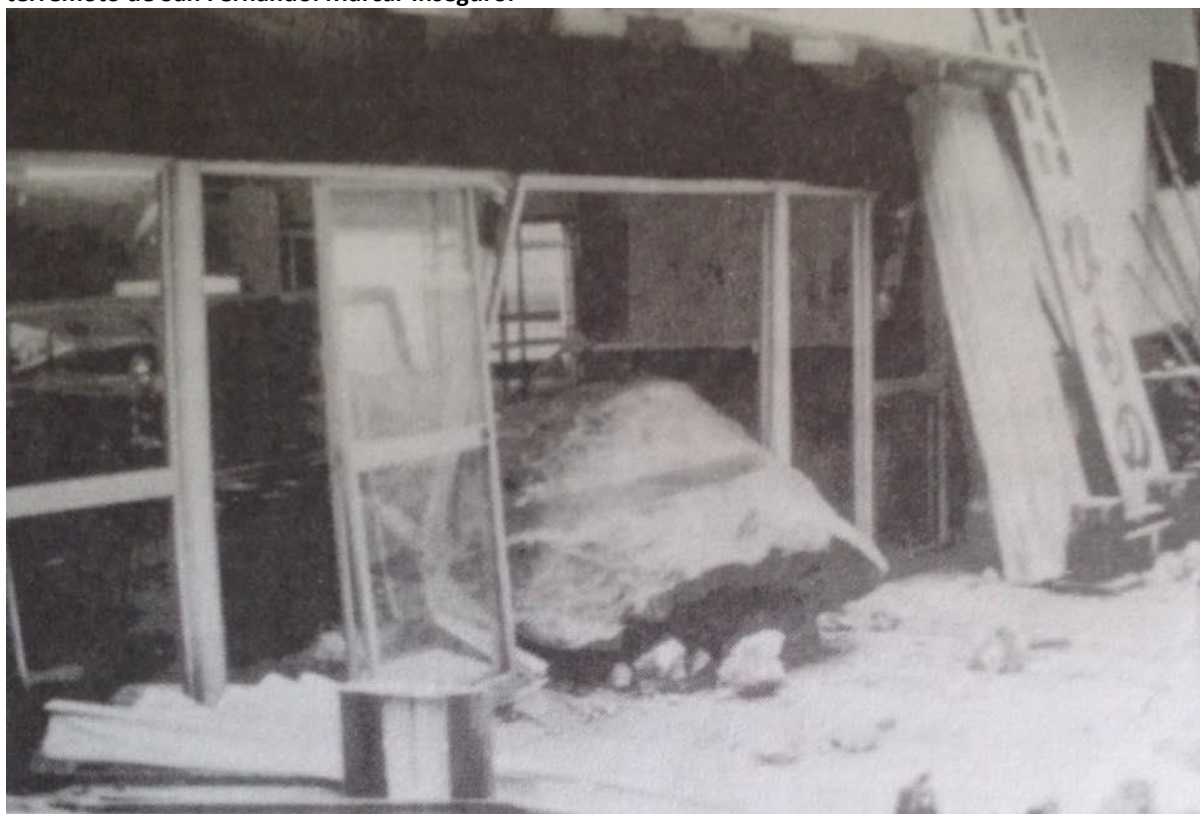
Figura 11-5 Entrada de una tienda destruida por caída de roca.
