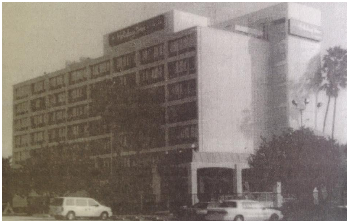
Figura E-14. Hotel de siete pisos de los Ángeles que fue severamente afectado por el terremoto de Northridge, 1994.
