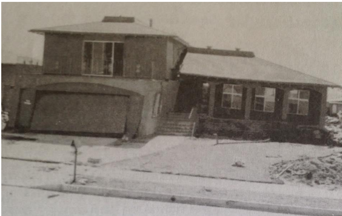
Figura 5-2 Existe un fallo estructural en el garaje el mismo que provoca su inclinación, también existe separación entre elementos de la estructura. Marcar Inseguro.
