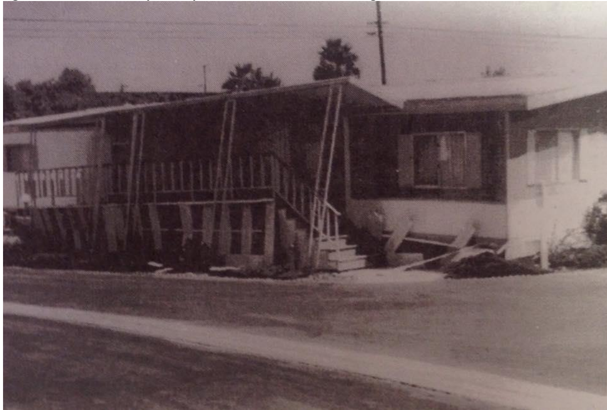
Figura 10-2 Casas móviles sin abrazaderas entre sus soportes de cargas verticales (cimentación) y la estructura normalmente sufren colapso con sismos moderadamente fuertes. Los daños de esta casa móvil no son únicamente los afectaciones entre el soporte vertical y la estructura, sino también el daño del porche y techo.
