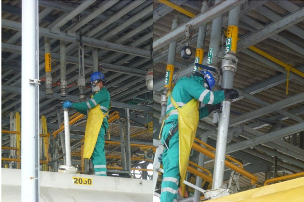
Figura No. 15 Instalación de tubería de descarga Fuente: Elaboración Propia
