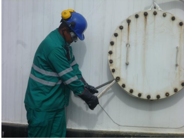
Figura No. 29 Colocación o retiros de pernos en manhole (cont.) Fuente: Elaboración Propia
