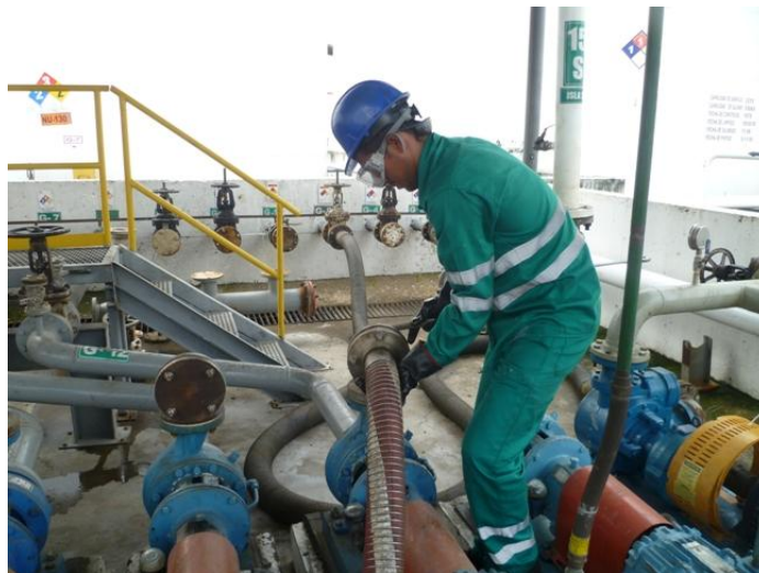
Figura No. 32 Colocación o retiros de pernos en mangueras (cont.) Fuente: Elaboración Propia
