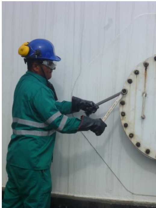
Figura No. 30 Colocación o retiros de pernos en manhole (cont.) Fuente: Elaboración Propia
