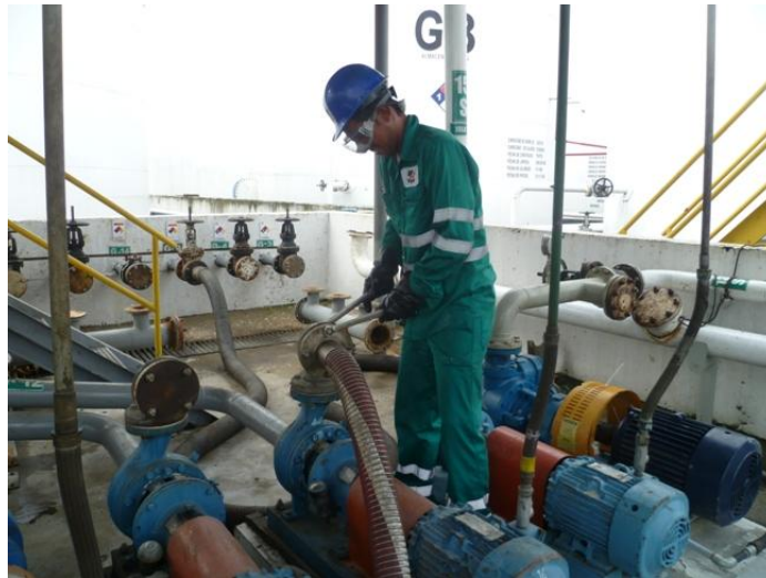
Figura No. 31 Colocación o retiros de pernos en mangueras Fuente: Elaboración Propia
