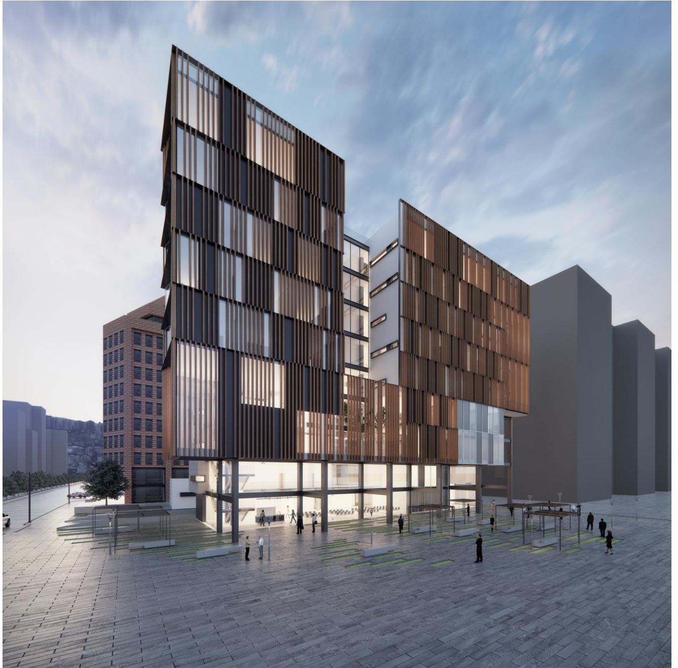
Escena exterior. Fachada
