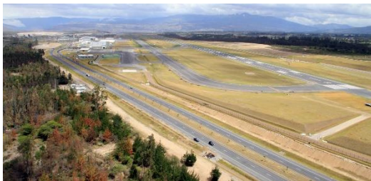
Nuevo Aeropuerto Mariscal Sucre 2015
