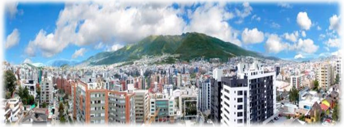
Figure 17: Vista Goya Apartamentos. Fuente: Constructora Rosero & Asociados
