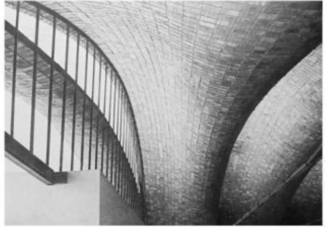
VISTA INTERIOR INGRESO
