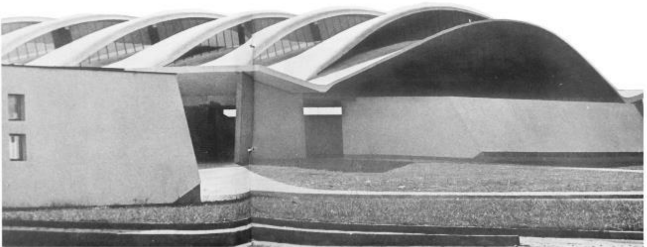
VISTA FACHADA SUR
