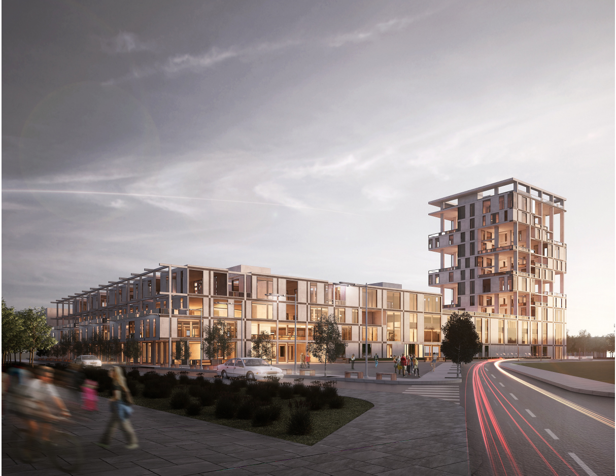
Figura 5.2 - Vista exterior fachada norte (elaboración propia)
