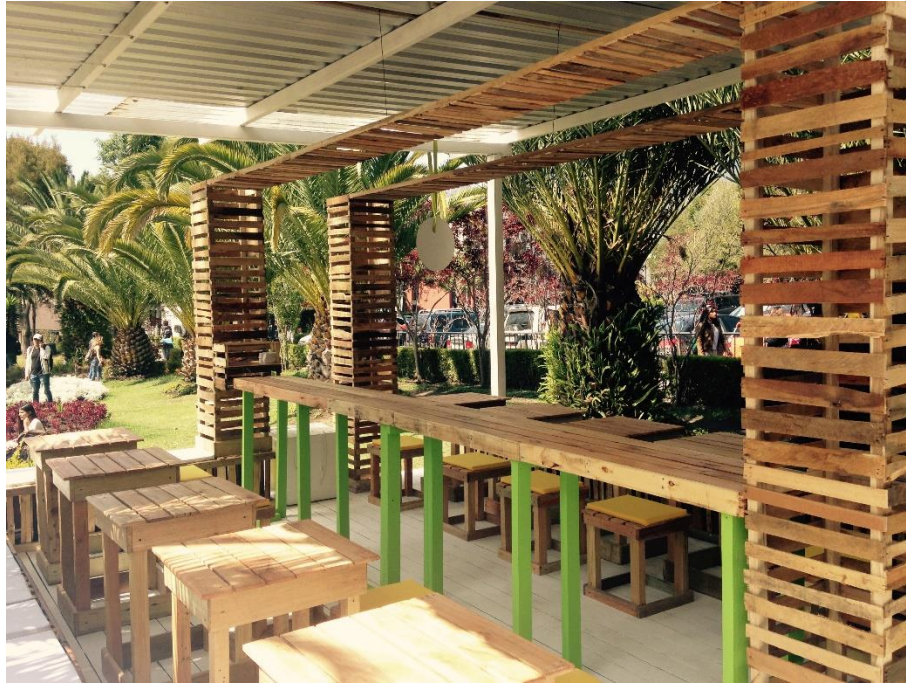
Anexo 7: Local terminado
