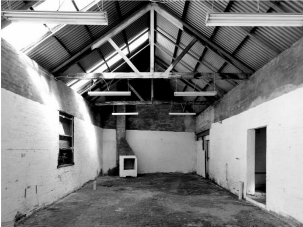
Figura 18. Interior de un pabellón del Ex Hospital Psiquiátrico San Lázaro
