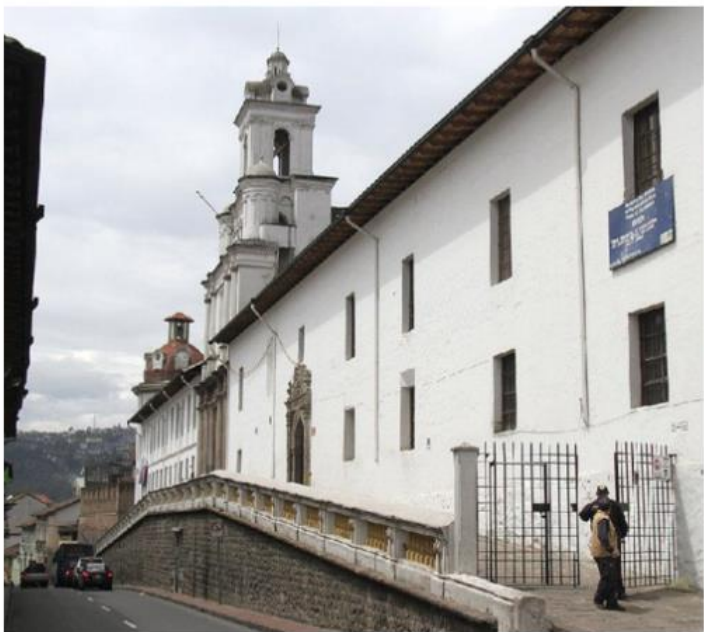
Figura 23. Fotografía desde la Calle Ambato.
