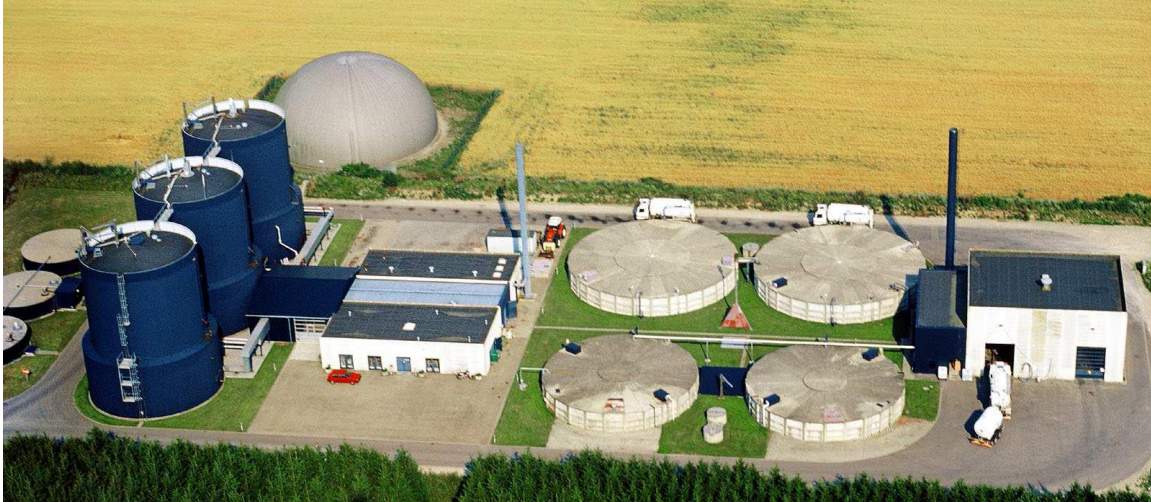
Figura 2.5. Planta de co-generación a partir de biogás (9)
