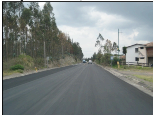
Fotografía 3.4 Recapéo de la vía
