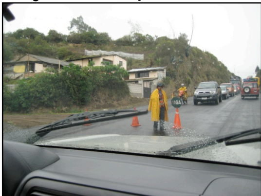
Fotografía 3.3 Trabajos en la vía
