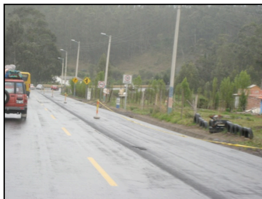
Fotografía 5.15 Trabajos en la Vía
