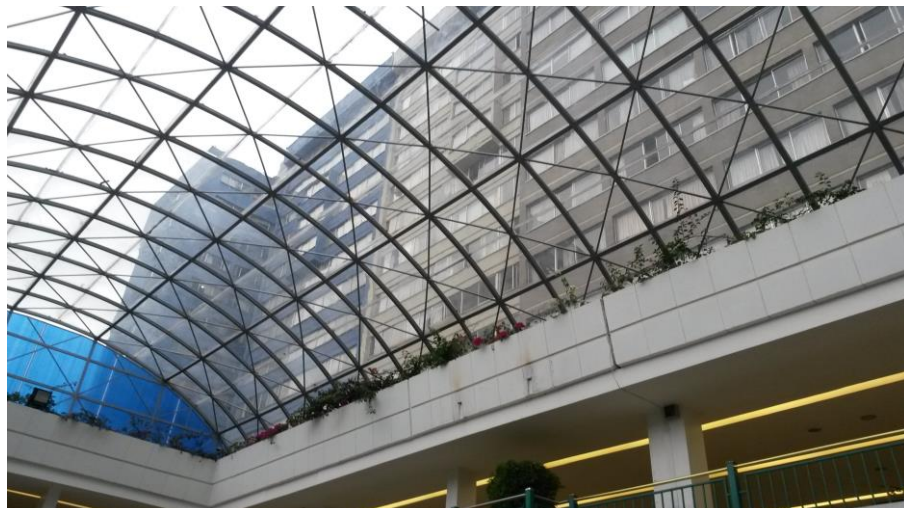
Figura 29. Vista interior de claraboya
