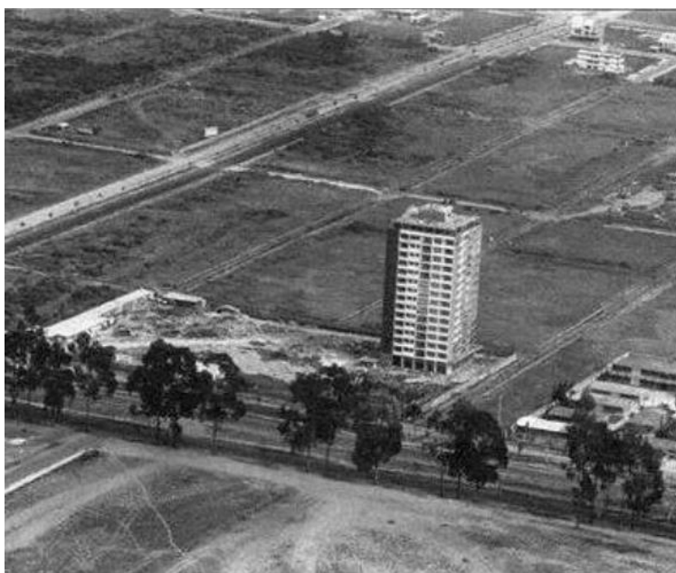
Figura 13. Primera torre Iñaquito en el sector de las Naciones Unidas
