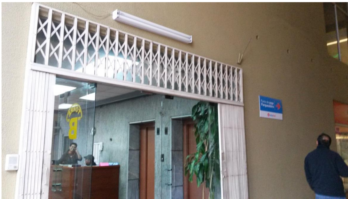
Figura 24. Acceso al lobby de Torre "B" por corredor lateral
