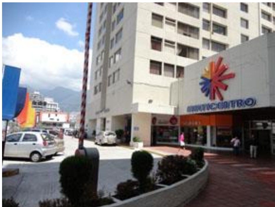
Figura 32. Vista exterior Multicentro
