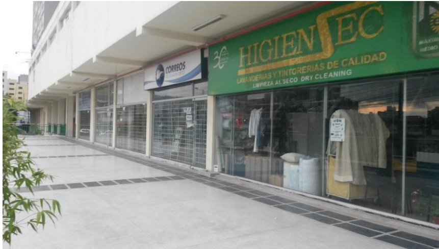
Figura 28. Vista exterior de fachada posterior. Vista desde plataforma financiera
