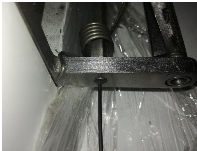
Figura 68. Montaje de apoyos
