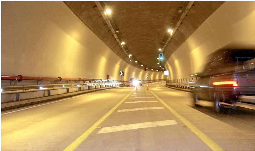
Ilustración 1 Túnel Guayasamín Interior Fuente: Jose Cartelone
