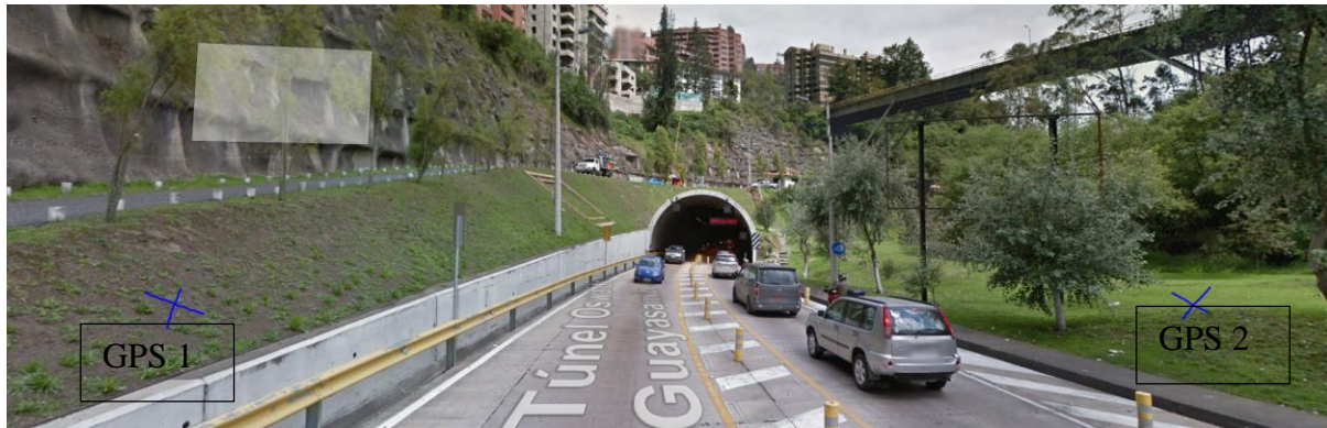
Ilustración 7 Túnel Guayasamín Fuente : Google Maps/ Autoría Propia
