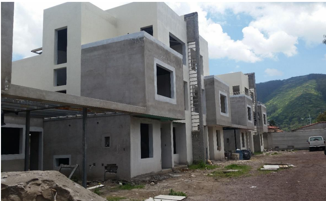
Ilustración 38 Vista Actual del Terreno
