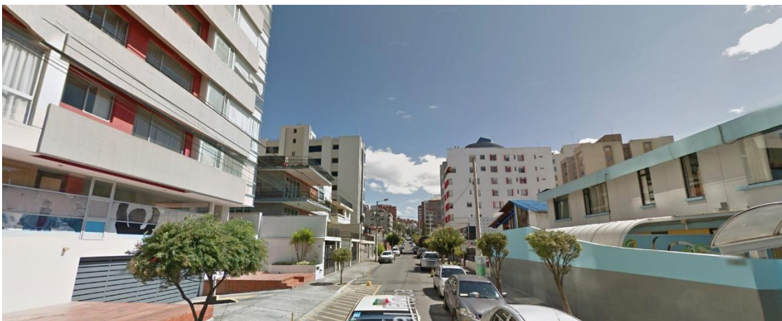
Imagen 3: Vista calle Gral. Roca
