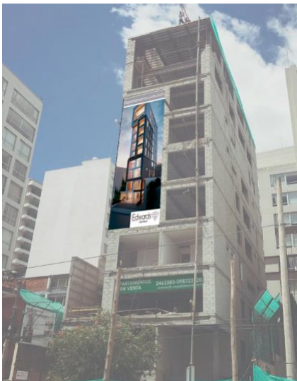
Imagen 46: Pendón en Obra
