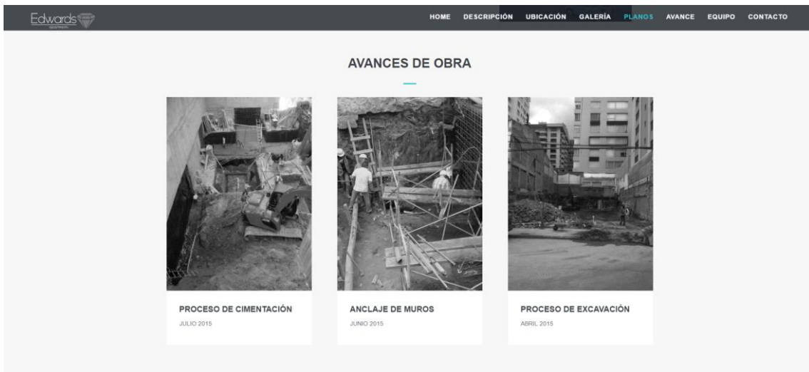
Imagen 61: Avance de Obra Página Web Edwards
