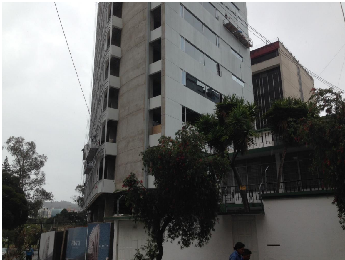
Anexo 12: Fachada Oeste
