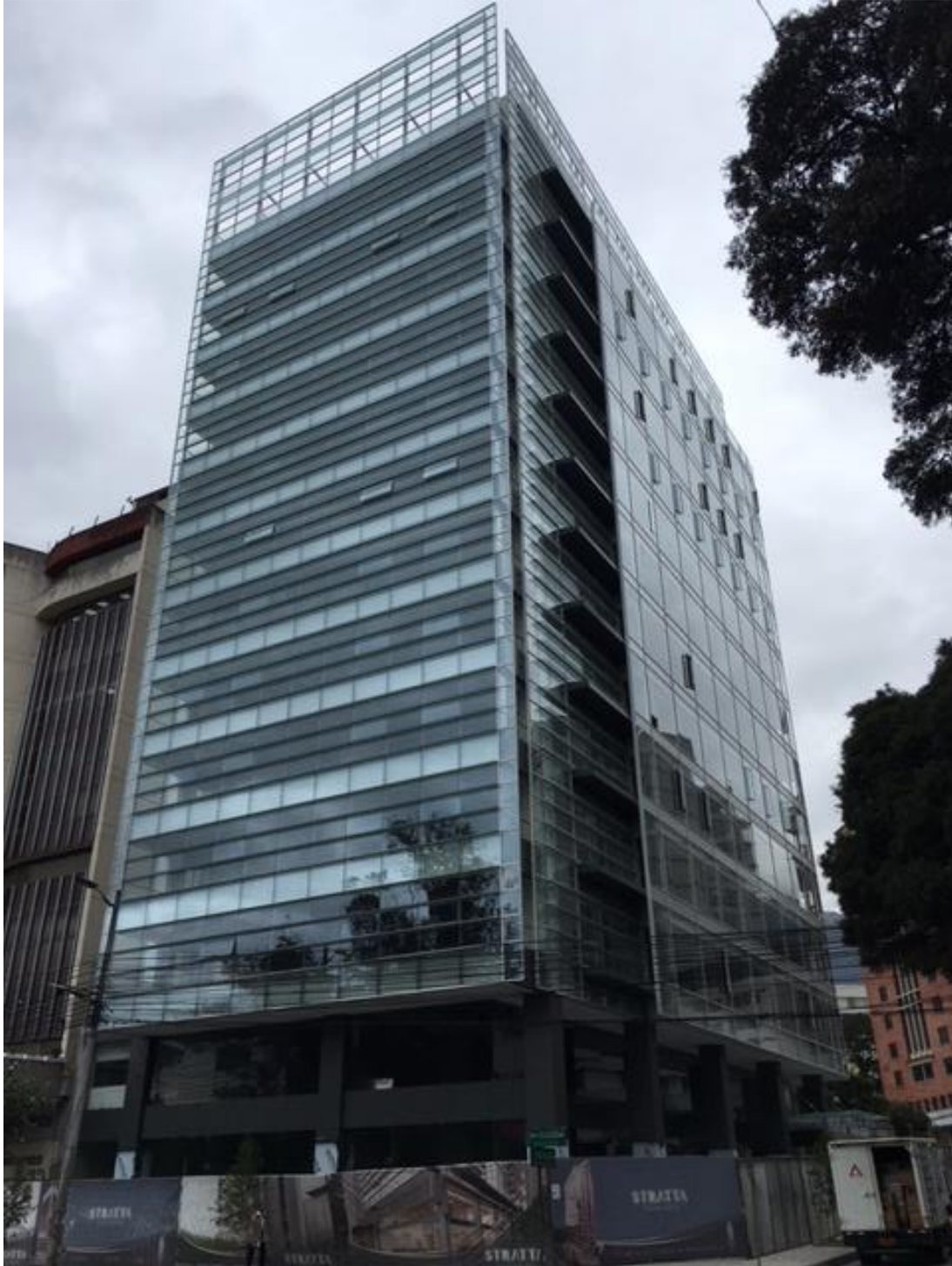
Ilustración 51: Vista Principal Nor-Oeste
