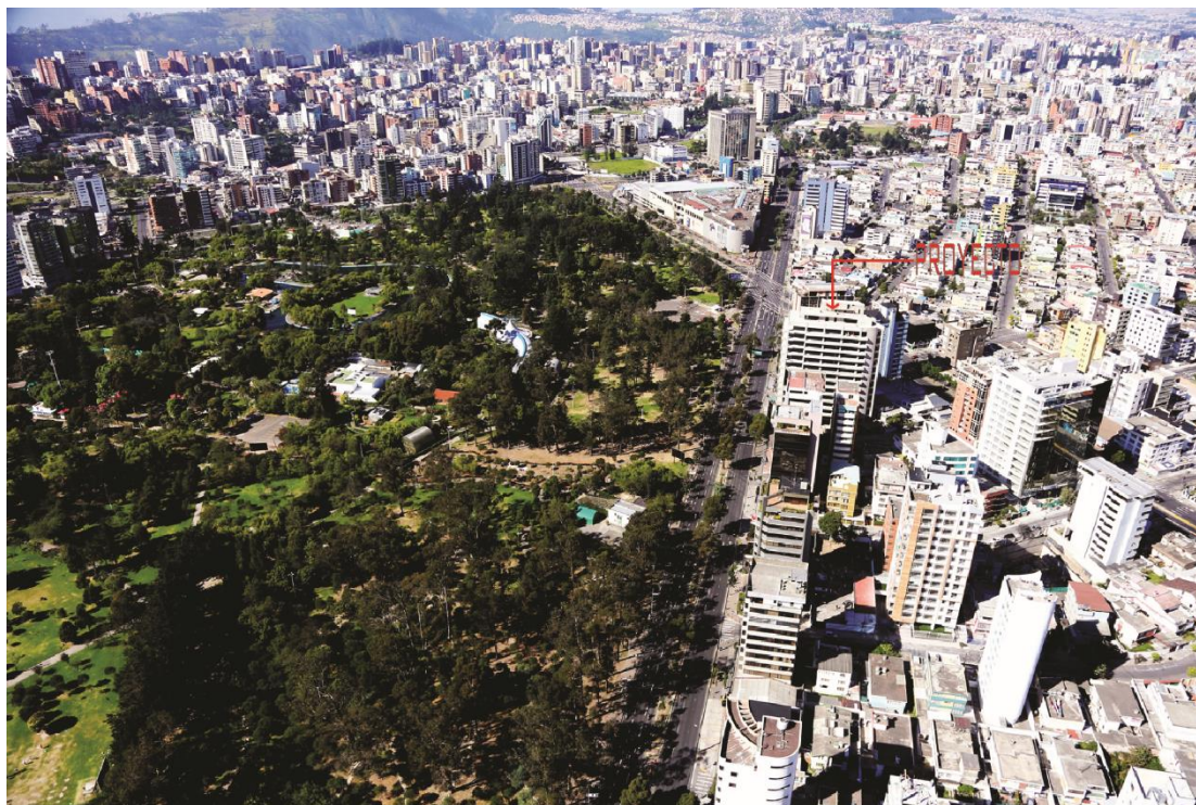
Ilustración 6: Vista Aérea 2. Barrio La Carolina
