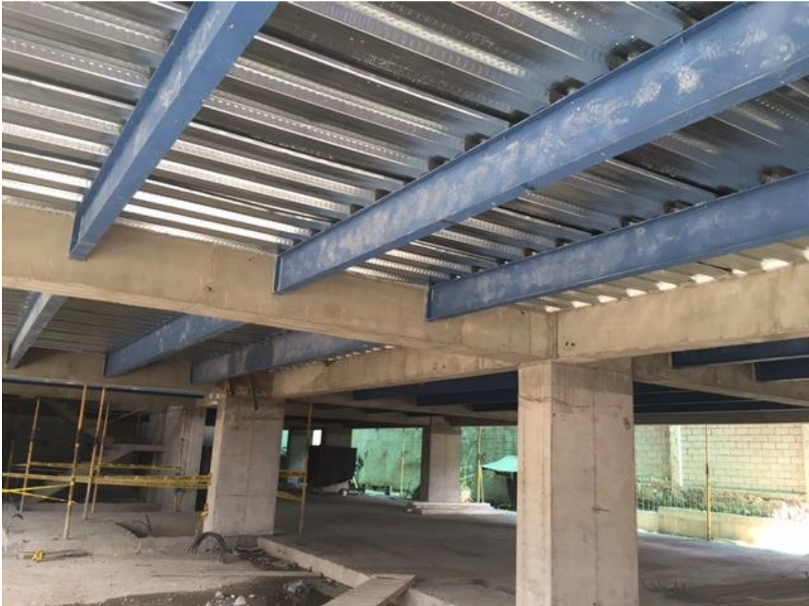
Ilustración 38: Sistema de Estructura Mixto
