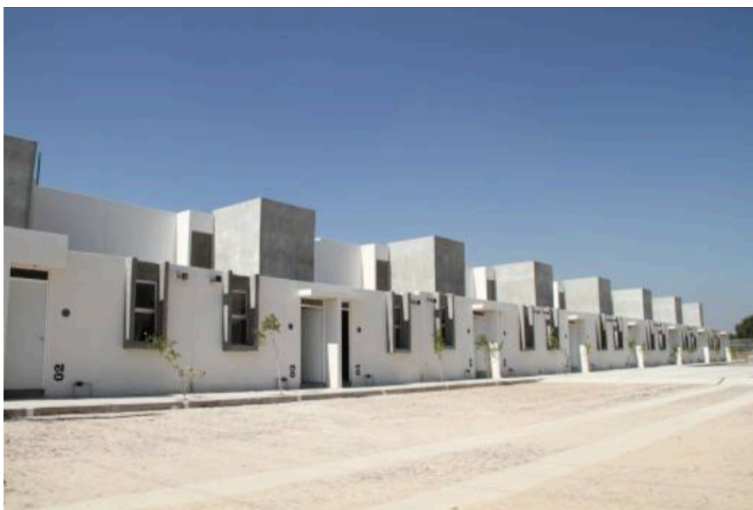
Ilustración 42 Fachadas de Casa Útiles Estudio Fuente: www.plataformaarquitectura.cl/casas-utiles-estudio
