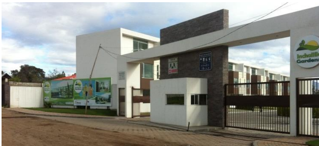
Imagen 5 Portón de Ingreso Fuente: http://www.inmobiliatico.com/ecuador/quito/valles/amaguana/proyecto-venta-inchalillo-gardens
