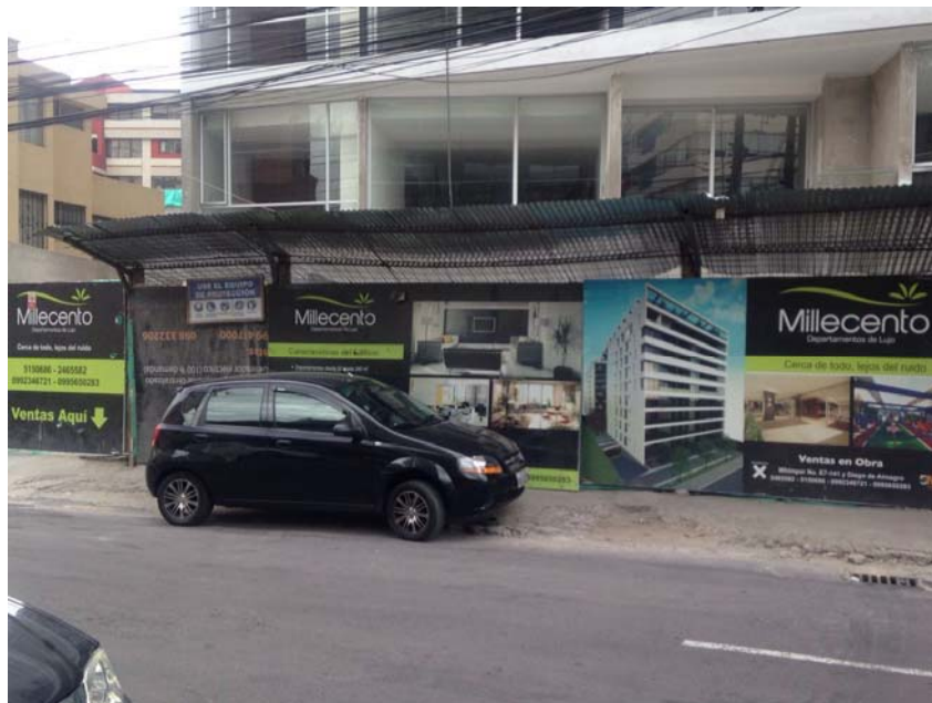
Ilustración 139: Exterior de la Obra-2016
