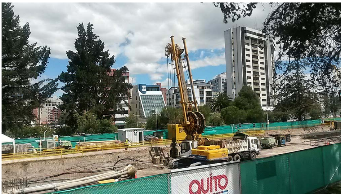
Ilustración 260: Inicio de excavaciones. Fuente: (QUITO E. M., 2016).
