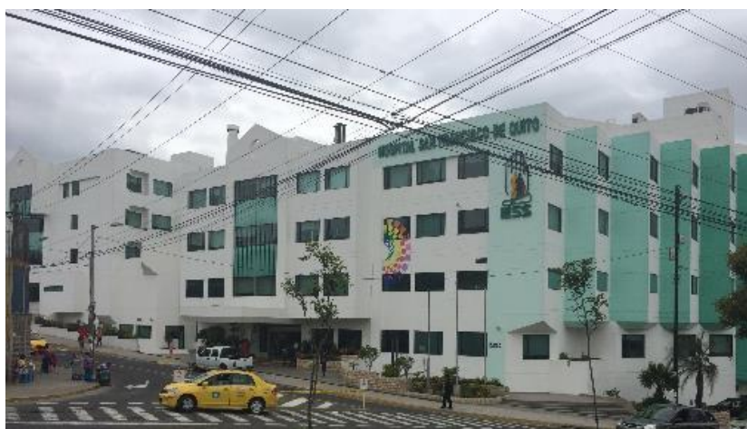
Ilustración 43 Hospital San Francisco de Quito
