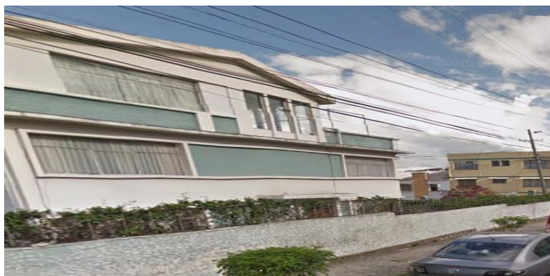
Figura 214: Viviendas lado derecho de la propiedad
