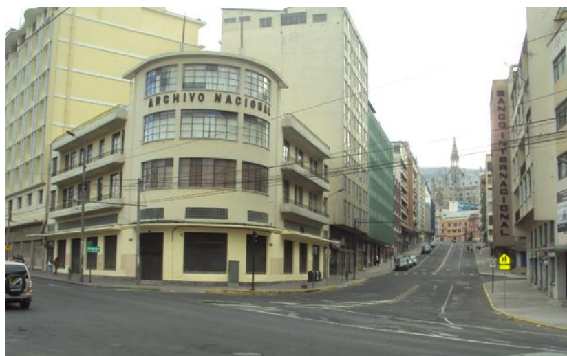
Figure 2 Edificio Archivo Nacional
