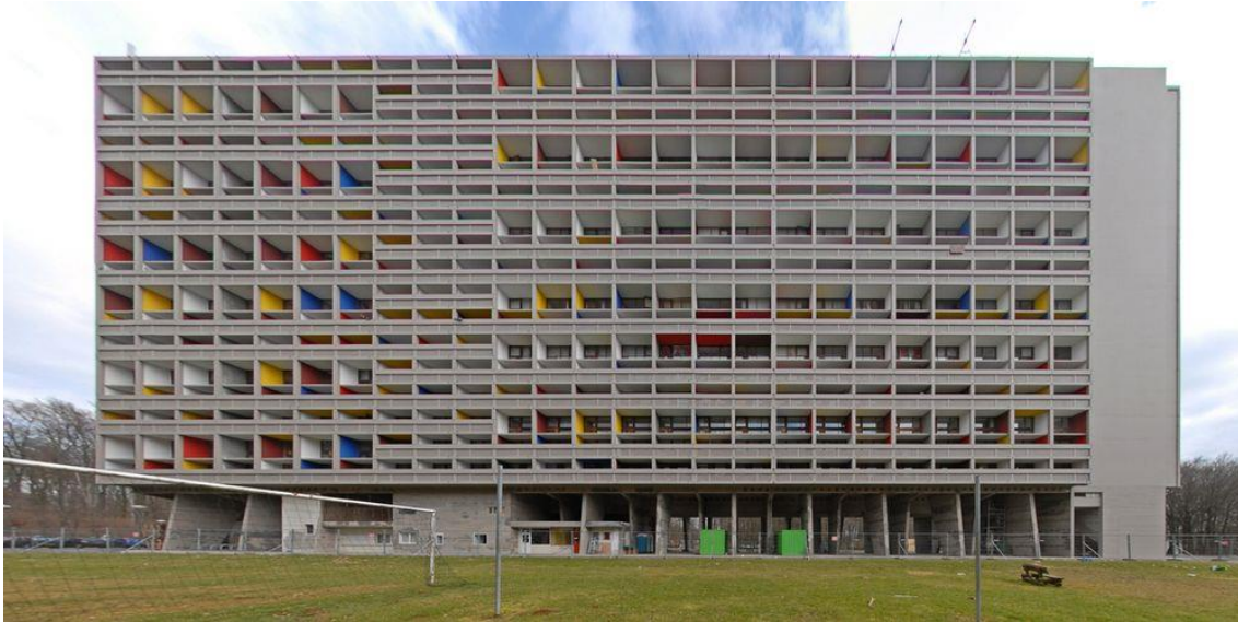
Figure 13 Unidad Habitacional de Marsella
