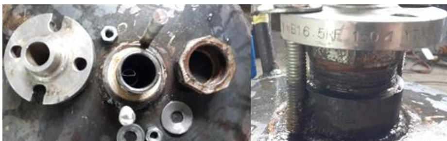
Figura 23: Instalación y sellado de sellos preno estopa
