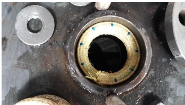
Figura 22: Instalación de sellos preno estopa
