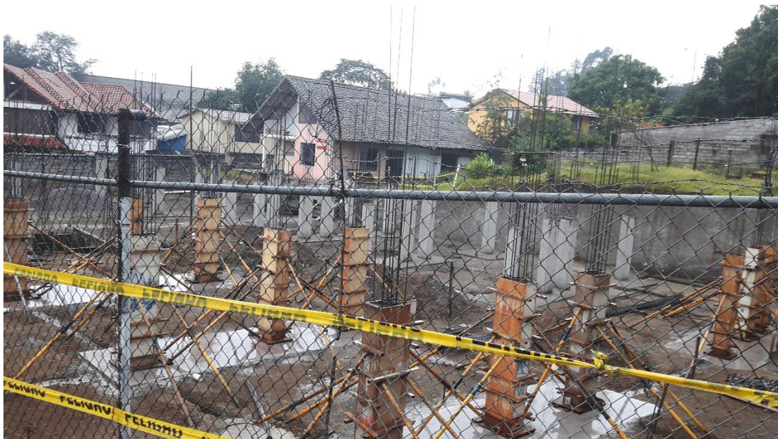
Ilustración 3. Estado actual del terreno.
