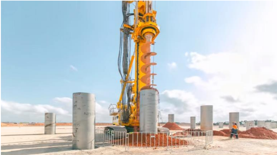
Figura 15 Excavación de pilotes (Inner boring inside driven steel tube piles, LNG plant, NT, 2015)
