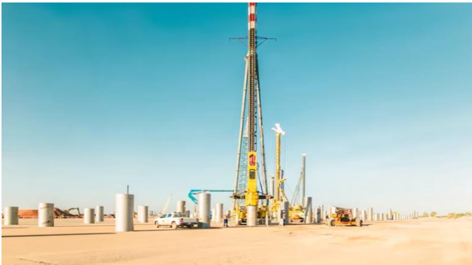
Figura 16 Colocación de armadura de pilotes (Inner boring inside driven steel tube piles, LNG plant, NT, 2015)
