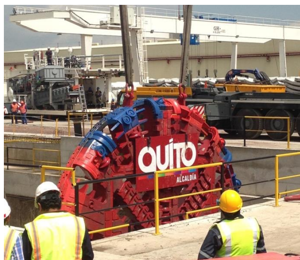
Figura 19 Descenso piezas tuneladora "La Guaragua"
