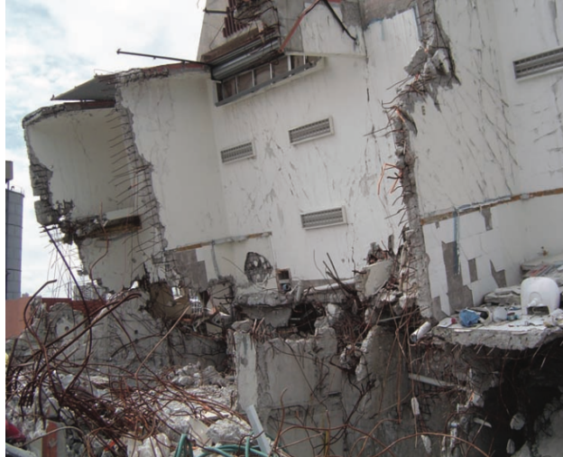
Figura 27. Edificio Alto Río 15 pisos y altura de 38m (Fuente: Boroschek, 2010)
