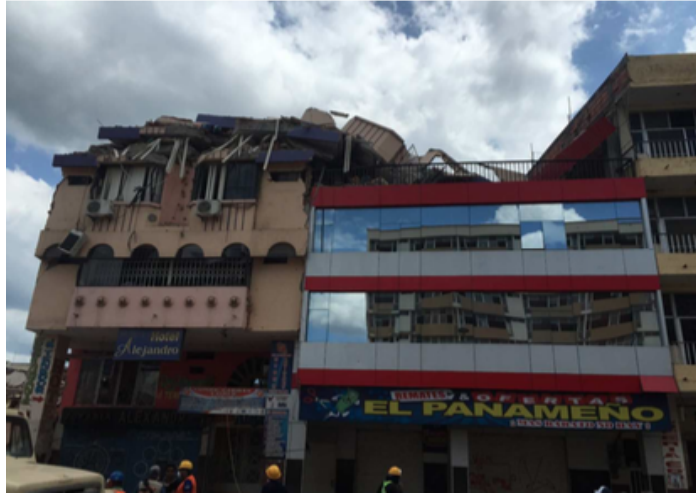
Figura 74. Efecto de golpeteo de estructuras (Fuente: GEER, 2016)
