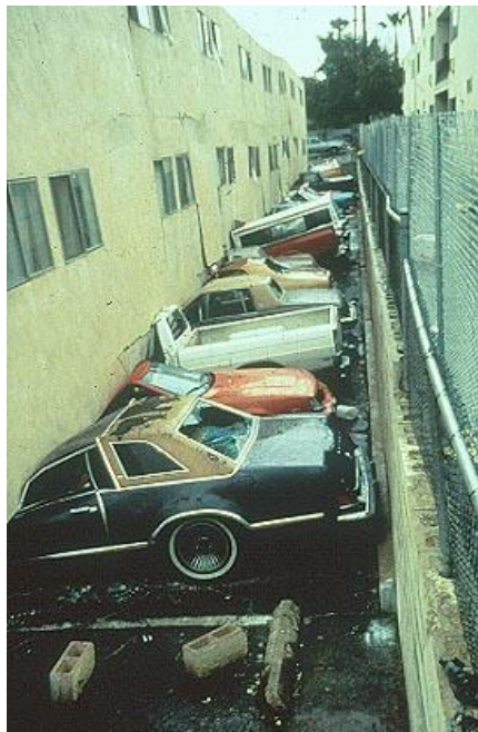
Figura 11. Colapso sobre parqueaderos en San Fernando Valley (Fuente: Alcorn, 1994)
