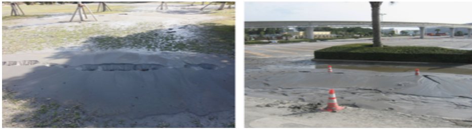
Figura 39. Licuefacciones, Tokyo Bay (izq). Disneyland (der) (Fuente: Bhattacharya et.al, 2011)
