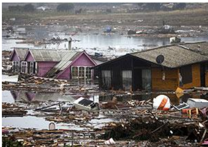
Figura 31. Destrucción de las viviendas tras el tsunami en Maule (Fuente: Pardo, 2010)
