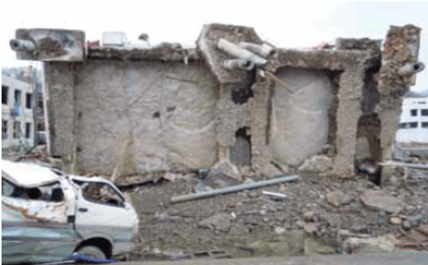
Figura 45. Volcamiento de una edificación en Onagawa (Fuente: Shibayama et.al, 2012)
