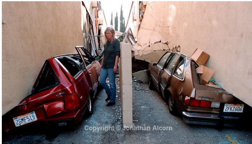
Figura 10. Falla en cabeza de columnas en San Fernando Valley (Fuente: SCEDC, 1994)
