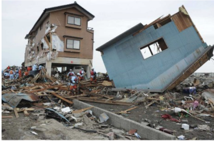
Figura 46. Estructura de madera desplazado por tsunami (Fuente: Shibayama et.al, 2012)
