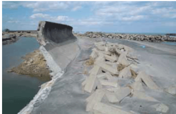
Figura 48. Medida de prevención contra tsunamis, Dique (Fuente: Shibayama et. al, 2011)
