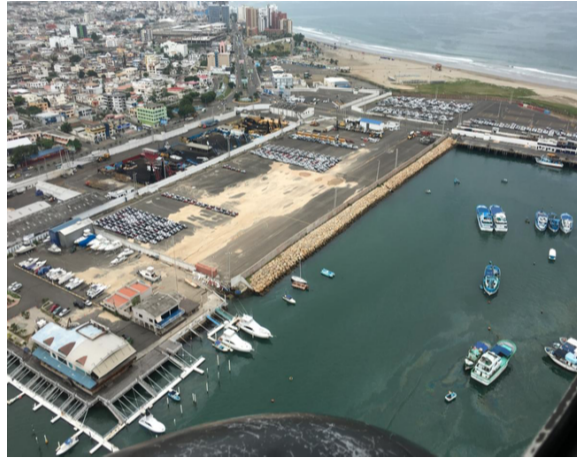
Figura 72. Puerto de Manta daños severos por Licuefacción (GEER, 2016)
