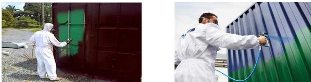
Figura 22: Pintando los contenedores con pintura anticorrosiva
