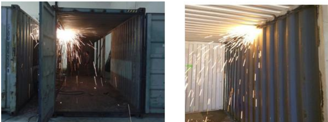
Figura 19: Proceso de cortado del contenedor, para hacer espacio donde se puedan colocar puertas, ventanas y sistemas de agua y electricidad
