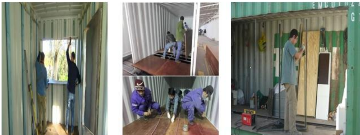
Figura 21: Adecuación de los interiores del contenedor, colocando los interiores
