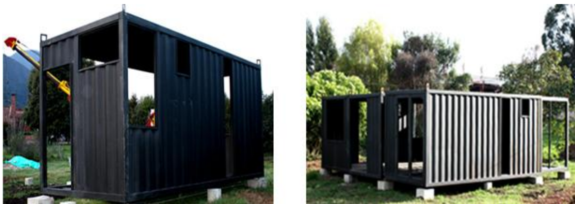
Figura 20: Proceso de cortado del contenedor, para hacer espacio donde se puedan colocar puertas, ventanas
