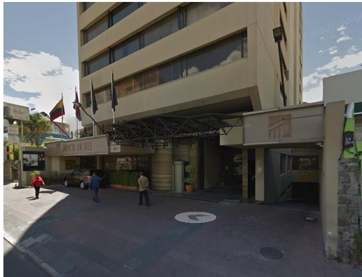
Figura 3: Entrada principal Hotel Akros
