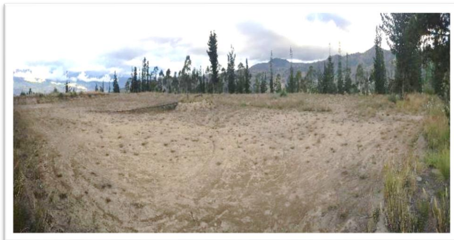
Fotografía 8 Trabajos iniciales de movimiento de tierras
