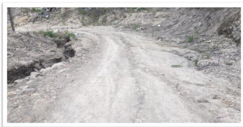
Fotografía 9 Vía actual de ingreso.
