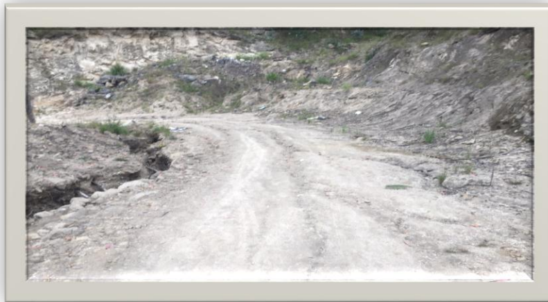
Fotografía 11 Vía de acceso Colina Club
