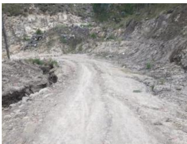
Fotografía 2 Camino hacia el proyecto segundo tramo
