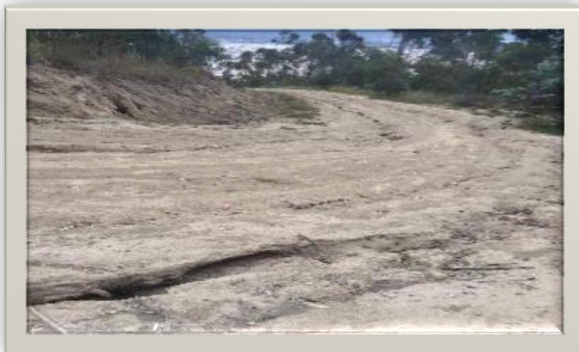
Fotografía 12 Vía de acceso Colina Club 2
