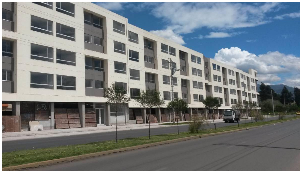
Fotografía 13. Fachada del proyecto Sol del Sur manzana F
