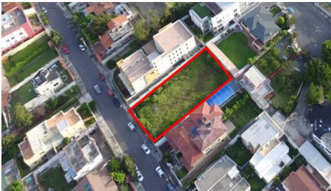
Figura 3.5 Vista aérea terreno Fotografía tomada por: Gustavo Tapia
