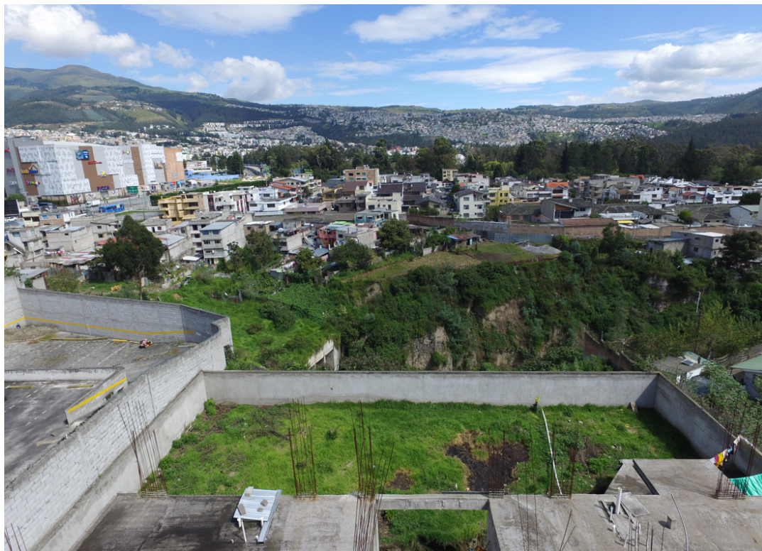
Figura 23. Vista desde el nivel +16.80 hacia el oeste.
