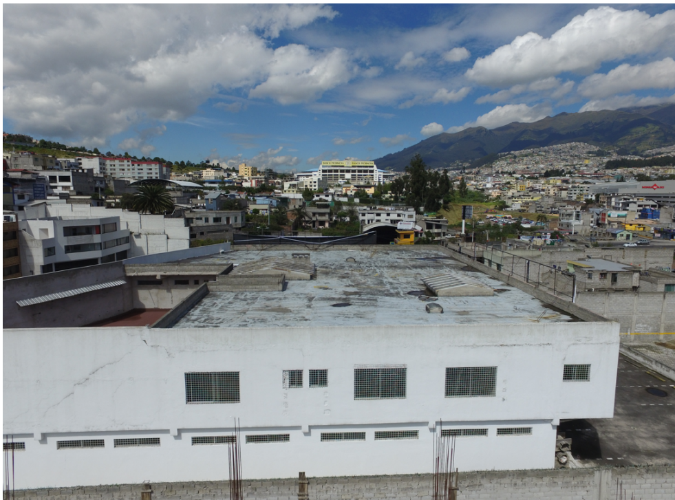
Figura 24. Vista desde el nivel +16.80 hacia el sur. Fuente: Investigación de campo. Elaboración propia.
