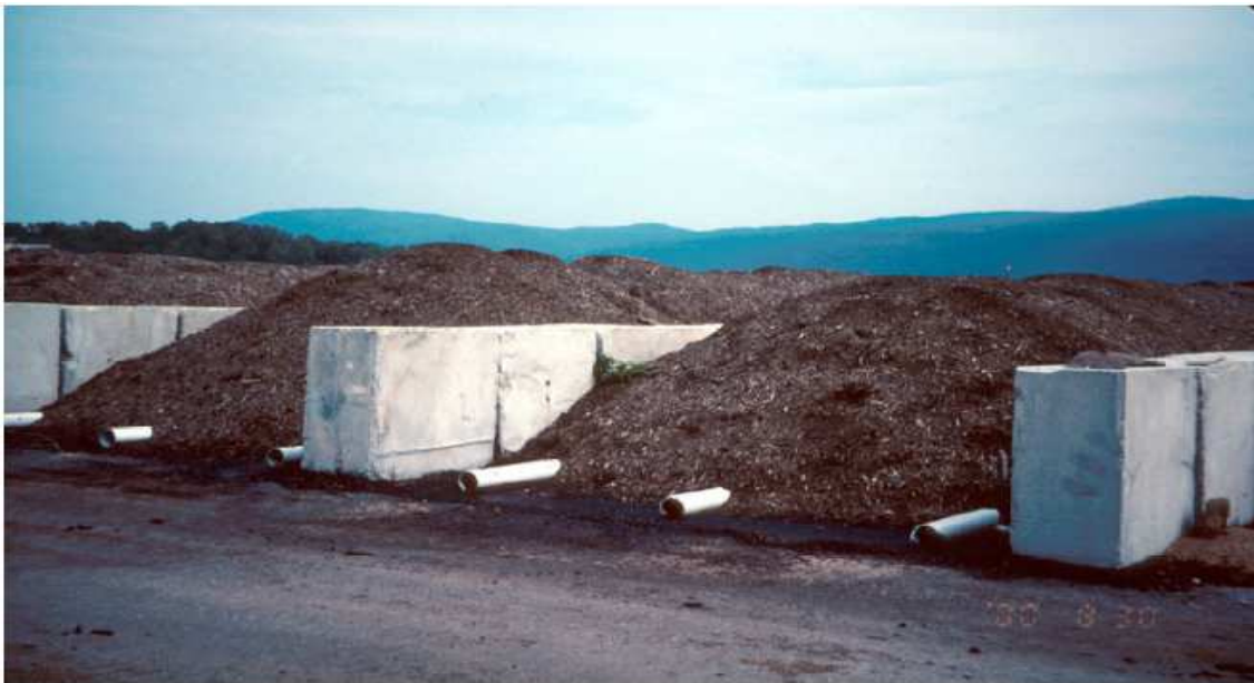
Gráfico 1: Pilas estáticas con aireación pasiva (Haug, P. 1993).
