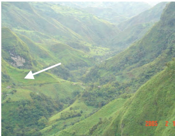
Relieves irregulares en la conducción, sobre el talud del río Angamarca
