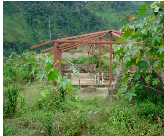
Terreno donde se estaba construyendo el campamento
