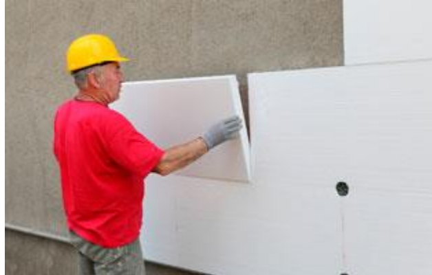
Figura 8: Poliuretano en viviendas (Merlin, 2016).
