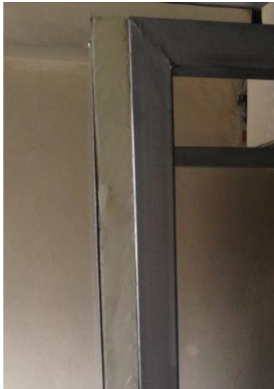
Figura 34: Poliuretano de 50 mm espesor y estructura principal.
