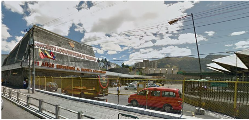
Figura 11. Vista desde la fachada principal Noroeste. Av. Calle Velasco Ibarra
