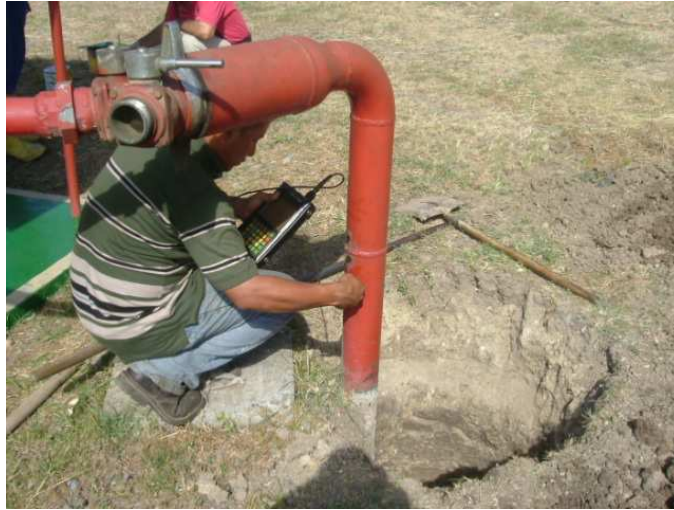
Gráfico 19. Punto #5 (Tubería de 4")
