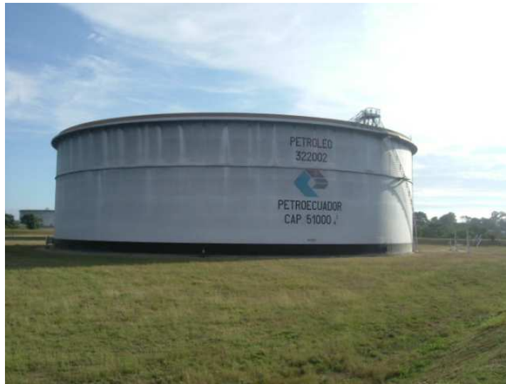
Gráfico 6. Tanques de almacenamiento de petróleo (Capacidad 51000 m 3 )
