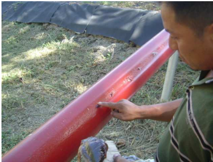
Gráfico 16. Punto #2 (Tubería de 6")
