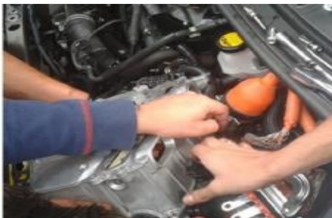
Fotografía 4: Desmontaje del conjunto Inversor del Toyota Highlander Fuente: Autor
