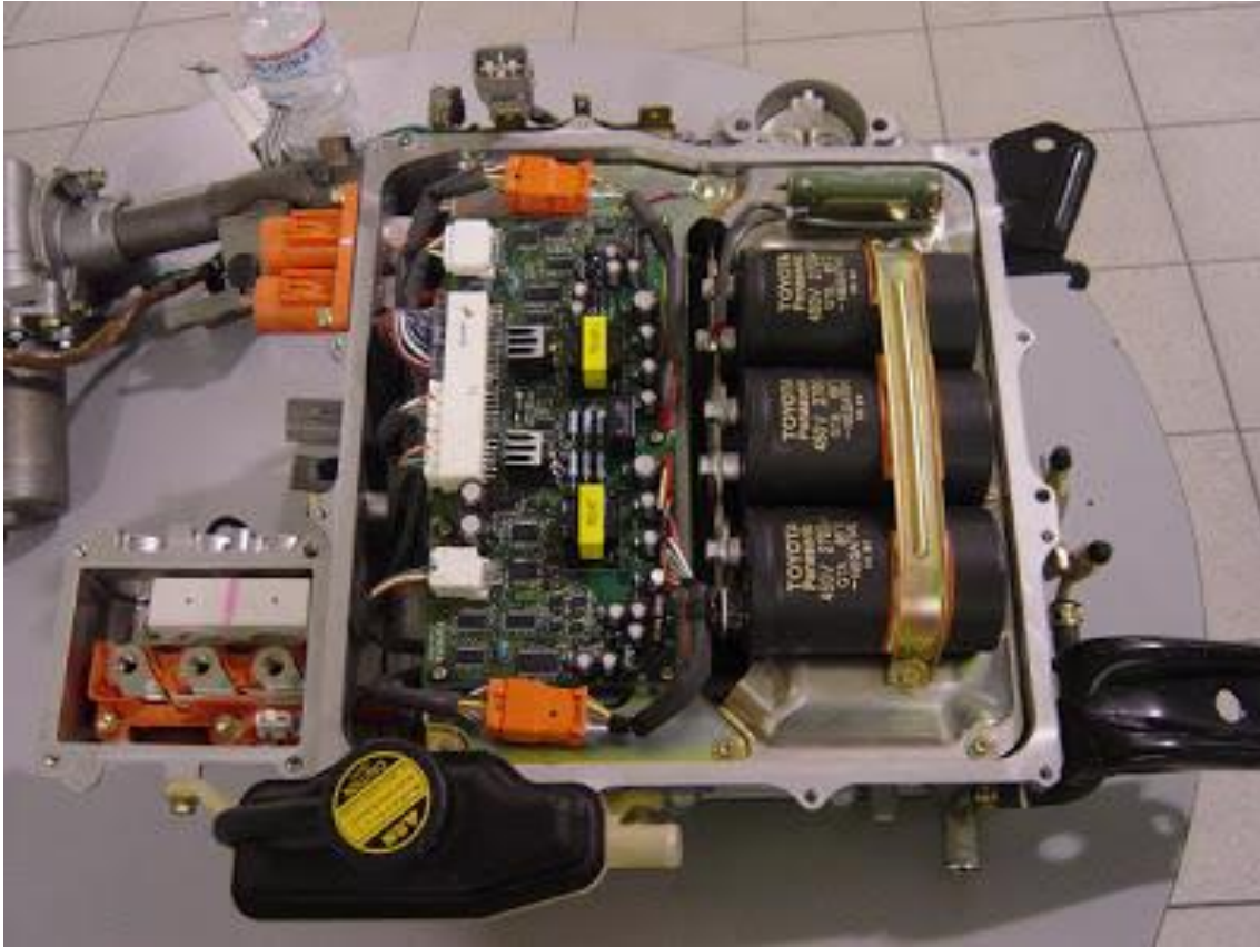
Fotografía 2: Interior del Sistema de Inversor
