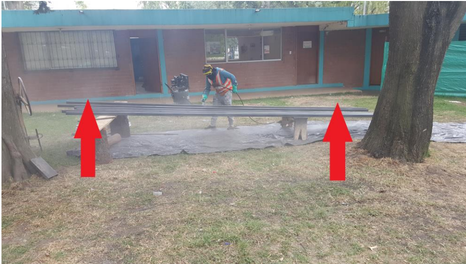
Figura 3: Instalaciones ya existentes.
