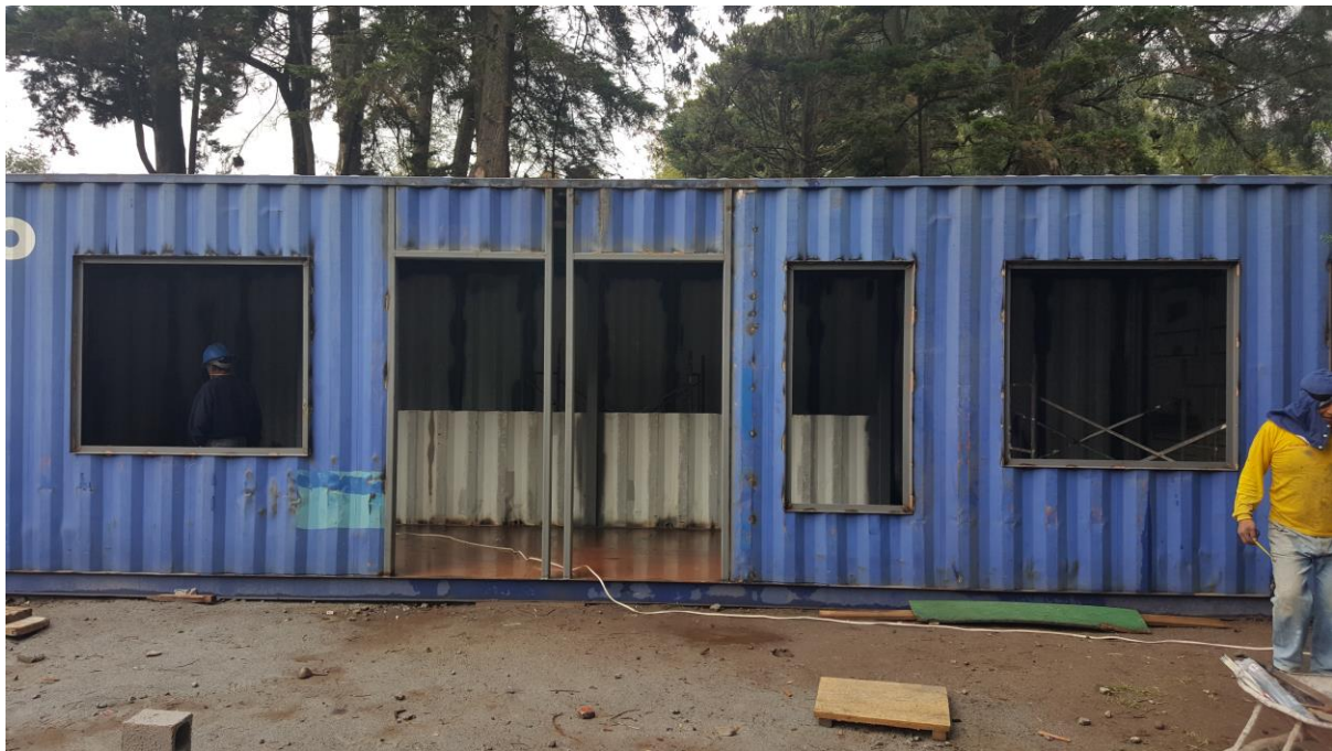
Figura 5 : Container en etapa de refuerzo.
