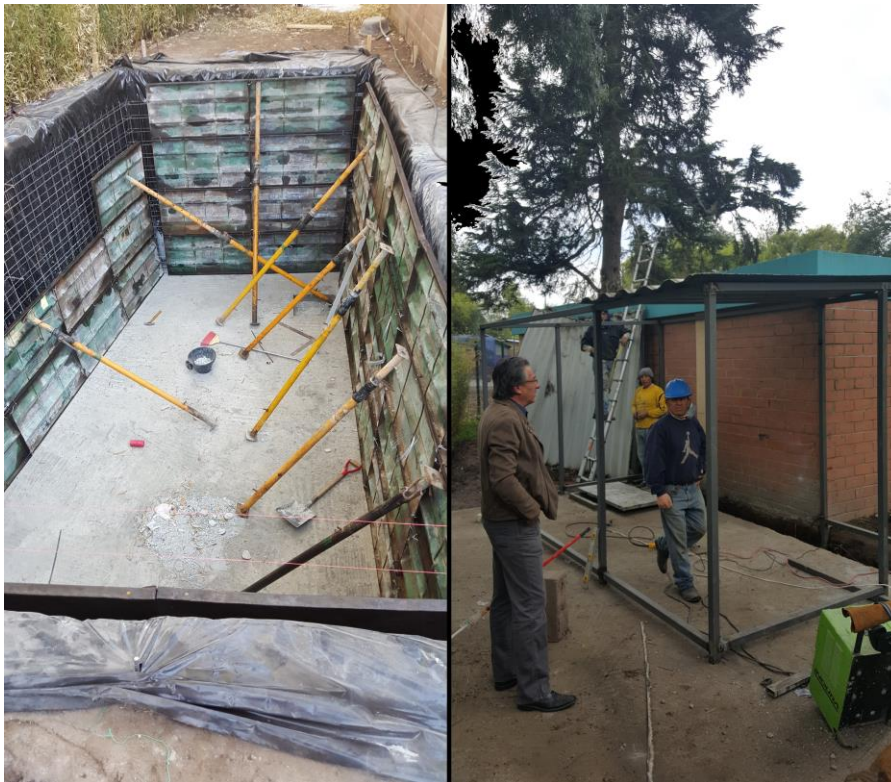
Figura 4: Construcción de cisterna y cuarto de máquinas.
