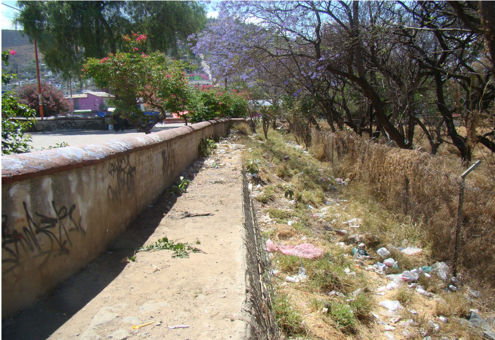
Figura 4. Espacio grieta espacial. Imagen, Garnica 2013.
