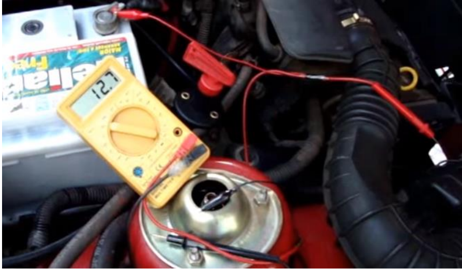
Figura 4. 21. Verificación de 12 v antes de instalar
