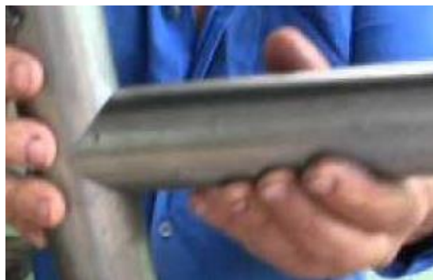
Figura 4. 10. Unión de tubos S355 con suelda MIG Fuente: El autor
