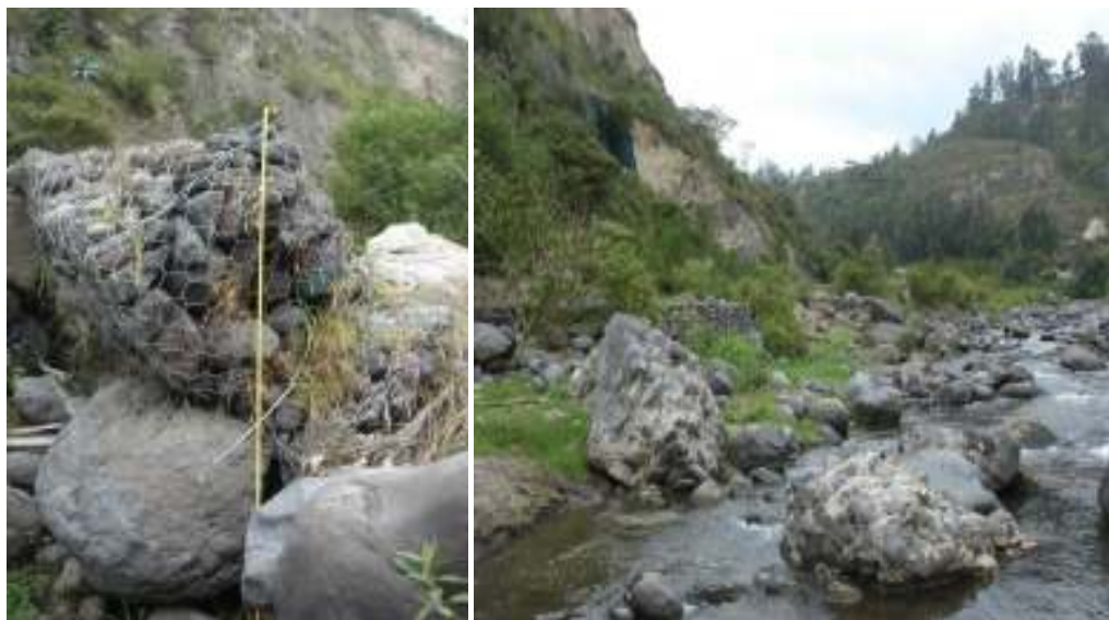
Figura 7-11: Altura de los espigones construidos y formación de las orillas virtuales.
