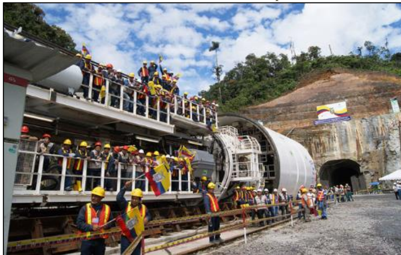
Ilustración 0.5: TBM, Túnel de captación
